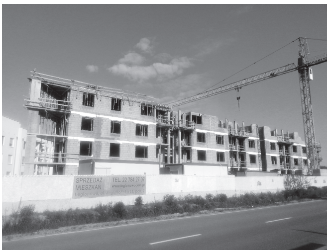
Budynek 10B w Jabłonie, fot. M. Janiszewska
